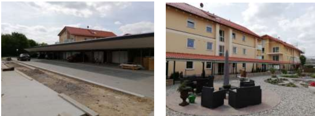
Abbildung 2: Carportanlage mit wohnungsbezogener E-Steckdosen
